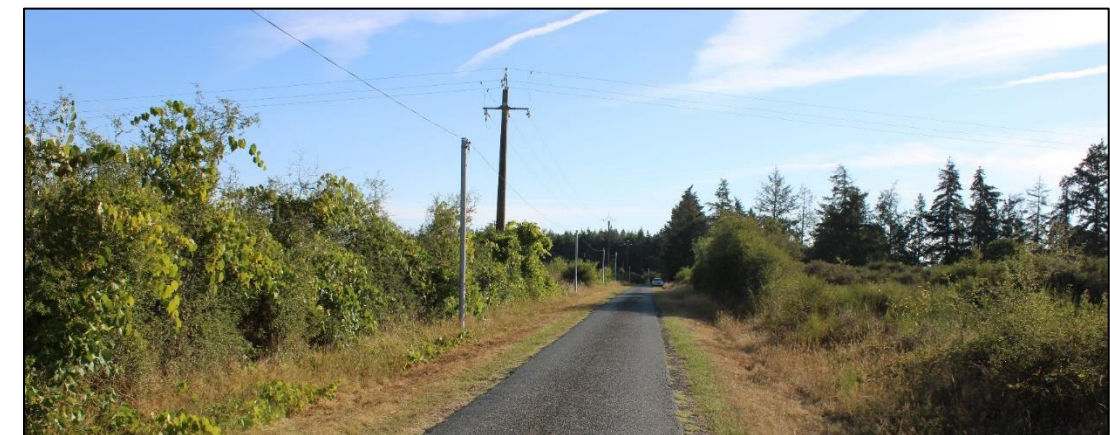
Figure 131 : Vue sur les lignes aériennes moyenne tension depuis le Chemin de la Chédelière sur la ZIP en direction du Nord-Est
