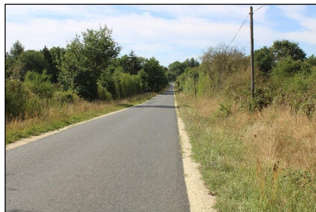
Figure 130 : Vue sur la RD 31 longeant la limite sud-est de la ZIP
